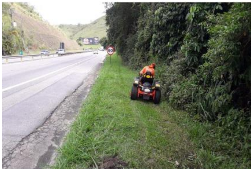
Figura 6.7 Via Lagos - Roçada mecânica
