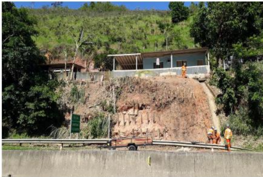
Figura 6.2 Via Lagos - Recuperação de Talude
