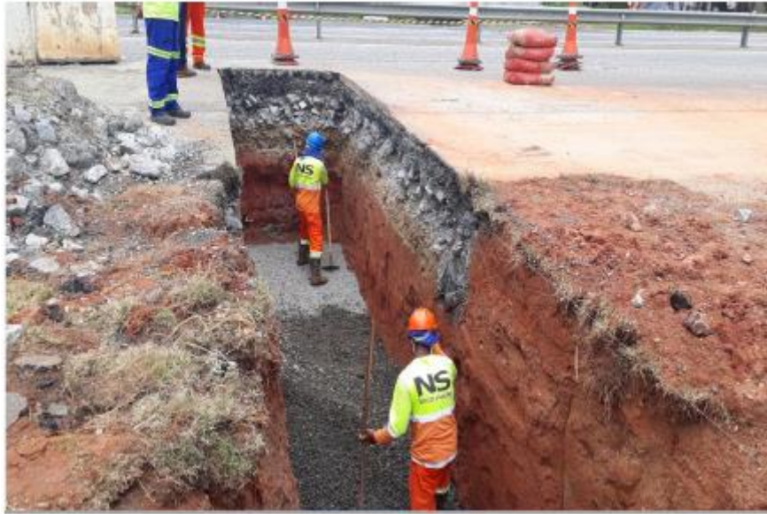
Figura 6.4 Via Lagos - Ampliação de Drenagem
