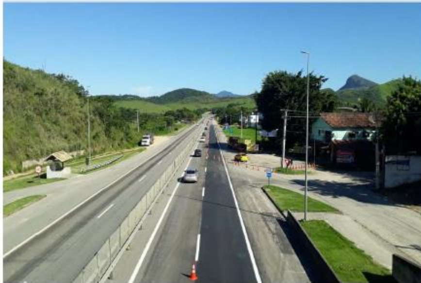
Figura 6.5 Via Lagos - Recuperação de Pavimento
