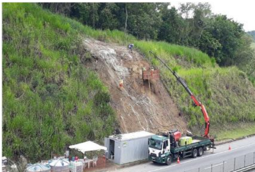
Figura 6.3 Via Lagos - Recuperação de Talude 2
